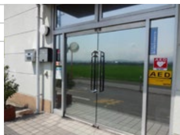
↑フィルム施工後の玄関 ※外側はミラーになっています
